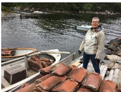
Teglsteinen til vestsida av taket kom også sjøvegen.
