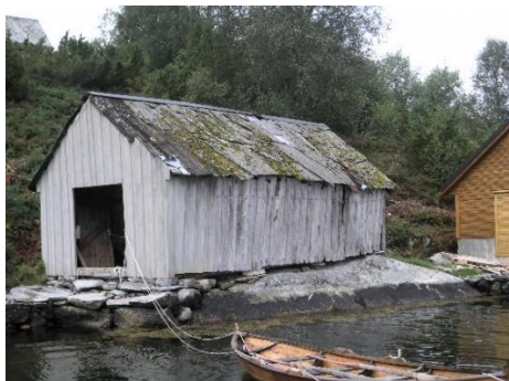
Førdestraumnaustet før demontering.
