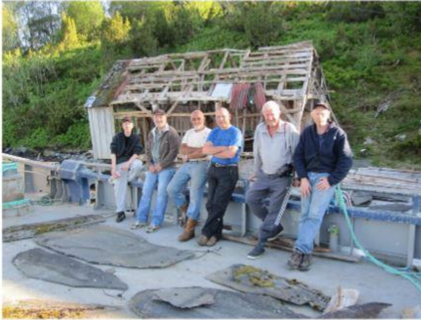
Mannskapet som demonterte villhellene av taket.
